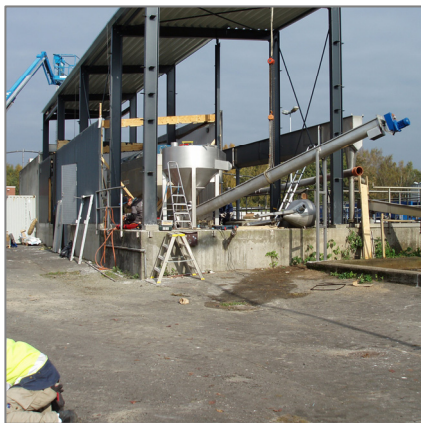
Sandtvätt HCSB 150. Tot. entreprenad utförd av Hydro Control.
